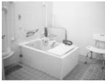
(上) 4月14日、体験入所の初日 (下) 安全を考慮した入浴施設
