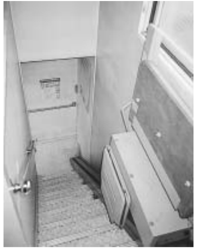
現在の診療所の階段には、足の不自由な方用の手動エスカレーターがつけられている。狭くてあぶない。
