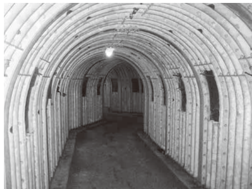
総延長30mの大きな防空壕。戦争の悲惨さを若い世代に伝え続けています（2000年に鉄筋で補強）
